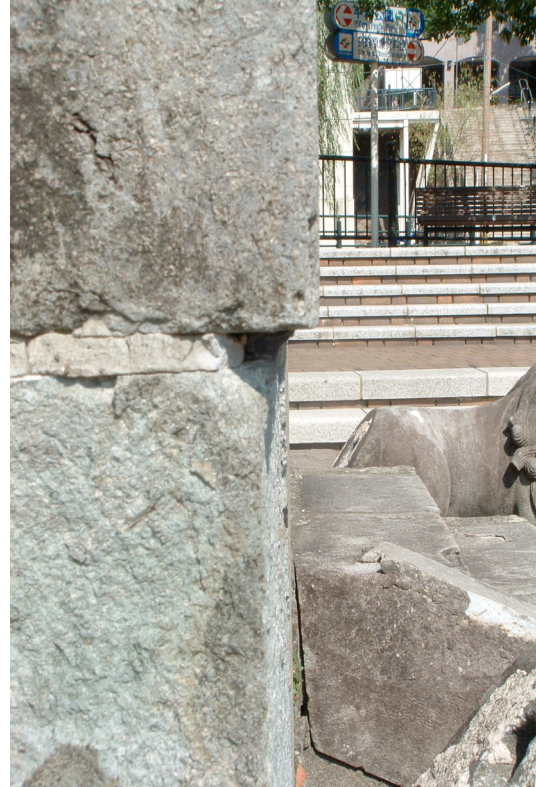
爆風により礎石の部分に生じたずれ
